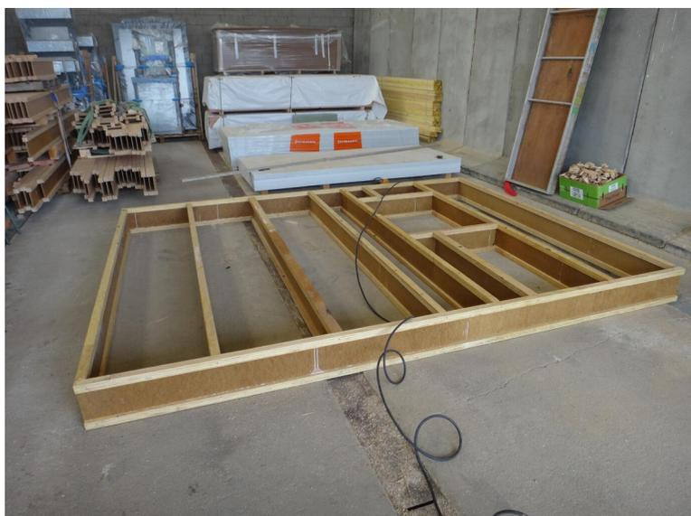
Cette maison sera construite à partir d'une ossature bois (24cm de largeur) en poutres en I et sera isolée en ouate de cellulose (non réalisée par BET Trak'terre) et bardée en lames de pin de douglas. La conception de ce bâtiment correspondra largement à la norme actuelle RT2012 aux niveaux thermiques et structurels. On atteindra des performances des bâtiments passifs au niveau de l'enveloppe et du fonctionnement.
