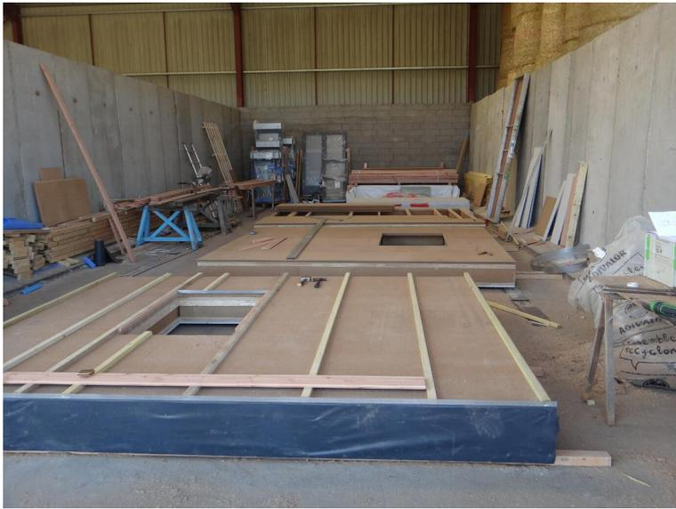
Après avoir retournés les caissons, ceux-ci sont recouverts d'un pare-pluie rigide bois de 35mm. Puis nous posons le litage permettant de fixer le bardage à plat en respectant la mise en place des ouvertures.
