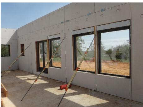
Le levage a été assuré à l'aide d'un télescopique de 10m. Le hors d'eau / Hors d'air s'est effectué en **7 jours** comme prévu.
