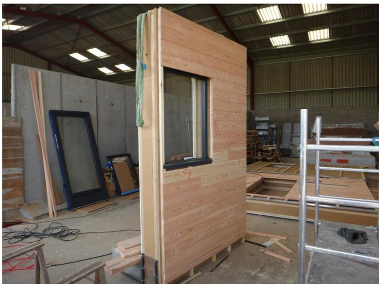
Insertion des menuiseries dans les réservations prévues. Finitions autour des cadres.
