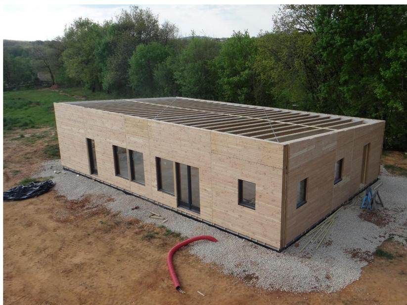
La toiture prendra une pente légère afin de gagner en volume habitable. La toiture sera fabriquée à l'aide de chevrons porteurs, afin de ne pas avoir de poteaux au milieu de l'habitation. Celle-ci sera isolée avec 36 cm d'isolant naturel.
